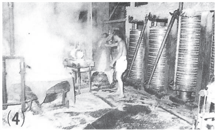
照片5 油壓式榨油機 26
